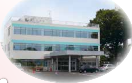
駐車場前の外来棟
